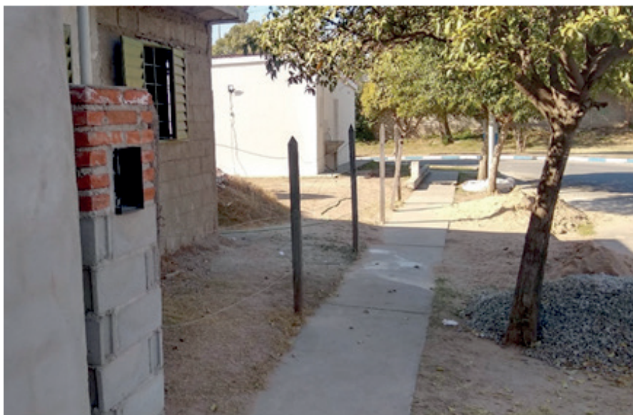
Figura 5: Construcción nueva en el patio de la casa.
